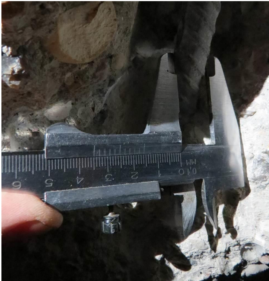
Рис. 3.2.5. Замер диаметра вертикального стержня пилона подвала
