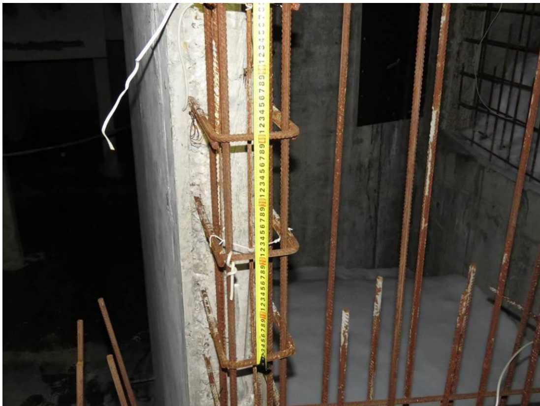
Рис. 3.2.9. Поражение арматурных выпусков поверхностной коррозией
