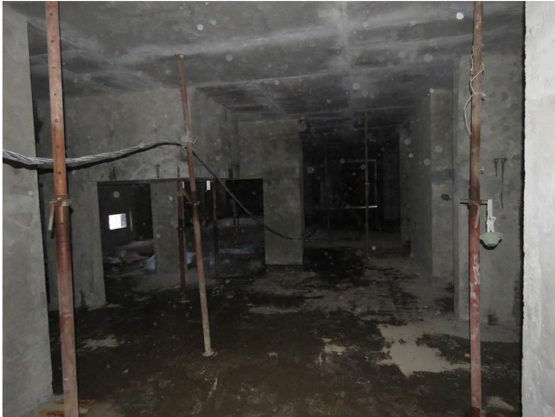
Рис. 1.5. Общий вид внутреннего пространства подвального этажа секции №1 между осями ММ/1-ДД/1, 5/1-27/1
