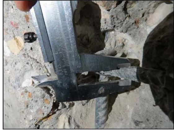
ФОТО 2. Уточнение диаметра рабочей арматуры монолитной ж/б стены подвала на пересечении осей «20/1» и «7» и «ММ/1».
