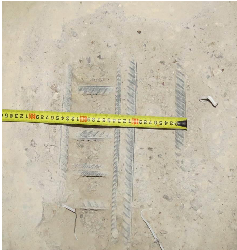
Рис. 3.1.5. Замер шага (230 мм) вдоль цифровых осей верхней зоны фоновое армирования фундаментной плиты секции 1 между осями ЖЖ/1-КК/1, 21/1-24/1
