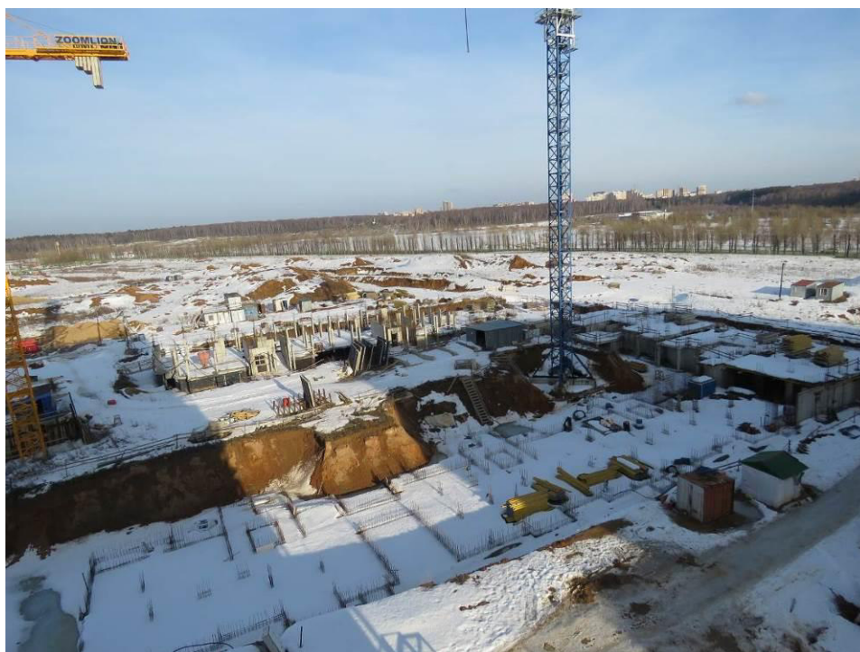
Рис. 3.1.1. Общий вид смонтированных фундаментных конструкции секций №№1-8. Фундаментная плита секции 9, 10, 11 не смонтирована
