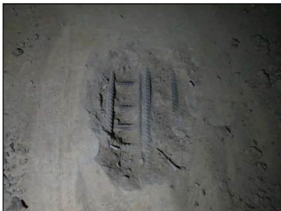
ФОТО 7. Общий вид вскрытия поверхности пола монолитной железобетонной фундаментной плиты расположенной между осями «22/1»-«23/1» и «ИИ/1»-«КК/1».
