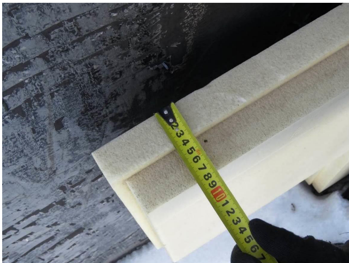
Рис. 3.2.8. Замер толщины утеплителя из пенополистирольных плит стен подвала
