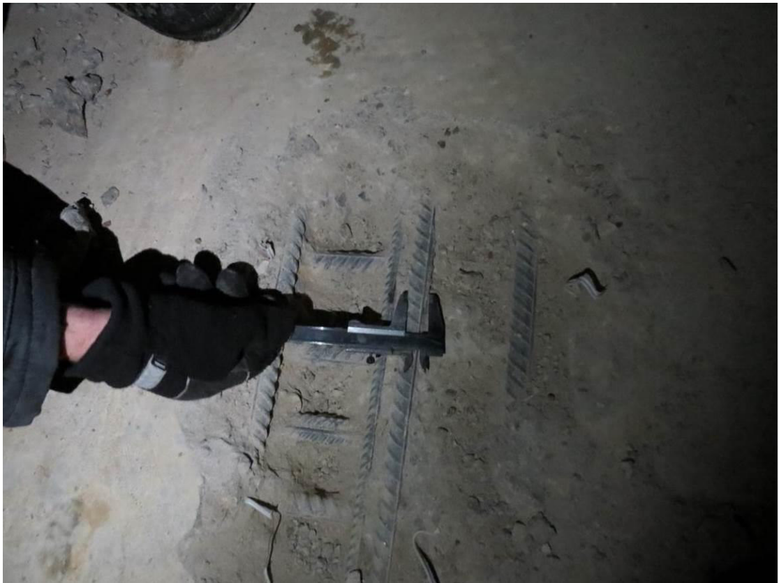
Рис. 3.1.7. Определение диаметра (20 мм) арматуры вдоль буквенных осей верхней зоны армирования фундаментной плиты секции 1 между осями ЖЖ/1-КК/1, 21/1-24/1
