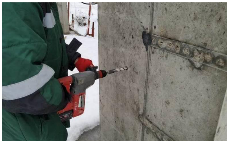
Рис. 4.2.1. Сверление отверстия в монолитном железобетонном пилоне 1-го этажа
