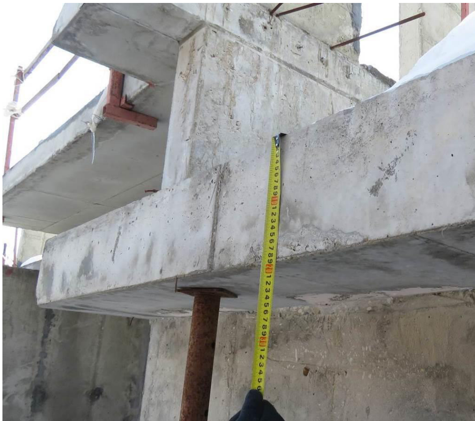
Рис. 2.2. Замер толщины плиты перекрытия подвального этажа секции №2 при помощи металлической рулетки
