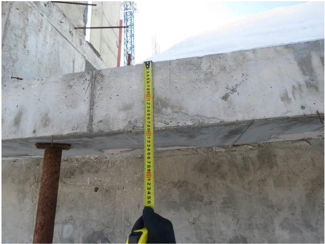
Рис. 3.3.3. Замер толщины монолитной ж.б. плиты перекрытия
