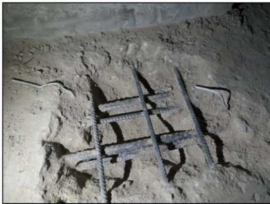
ФОТО 13. Общий вид вскрытия поверхности пола монолитной железобетонной фундаментной плиты расположенной между осями «19/1»-«20/1» и «Ю/1»-«АА/1».
