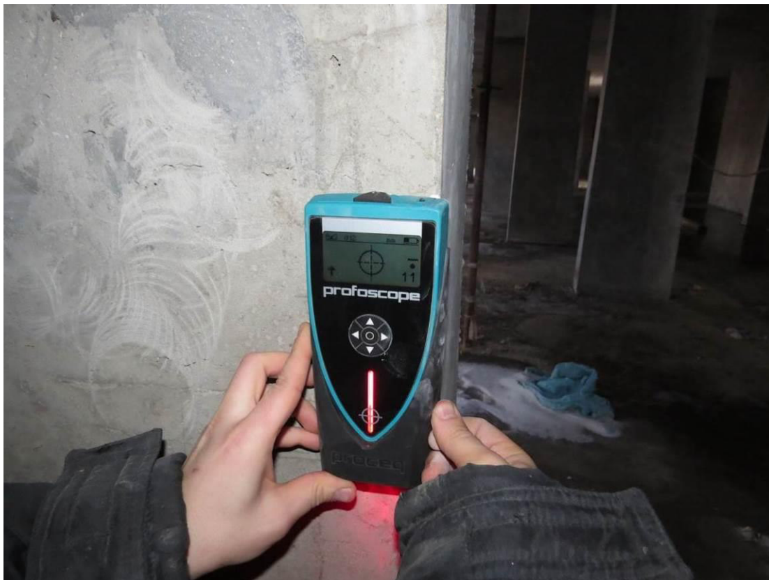
Рис. 3.2.7. Определение толщины защитных слоев бетона монолитного железобетонного пилона подвала
