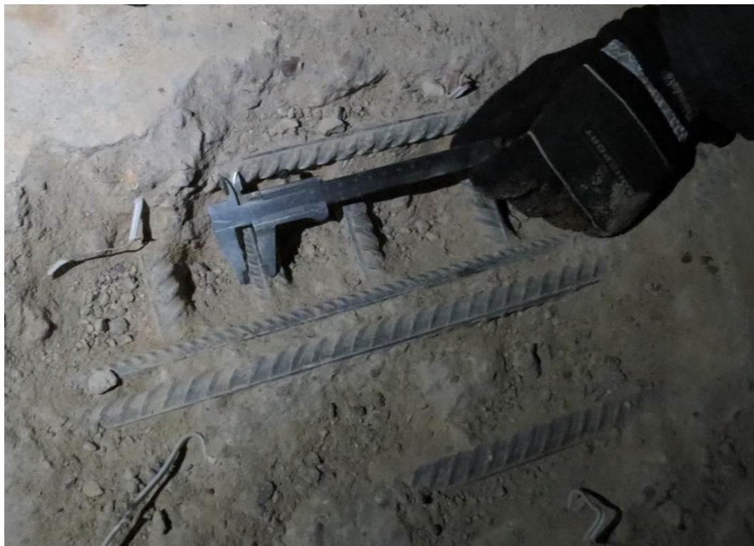
Рис. 3.1.8. Определение диаметра (12 мм) арматуры вдоль буквенных осей верхней зоны армирования фундаментной плиты секции 1 между осями ЖЖ/1-КК/1, 21/1-24/1
