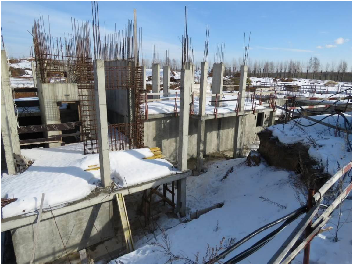
Рис. 3.2.1. Общий вид возведенных конструкций
