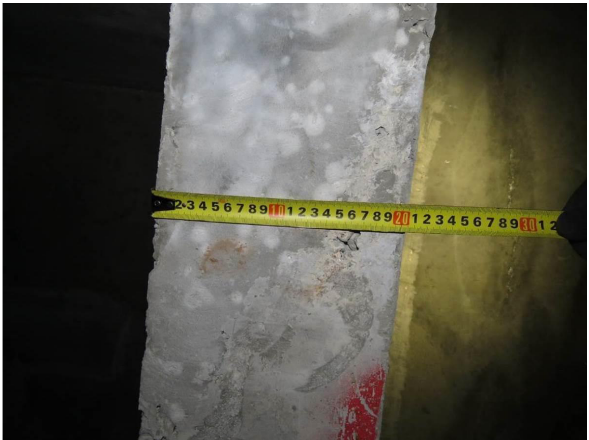
Рис. 3.2.2. Замер толщины монолитной ж.б. стены
