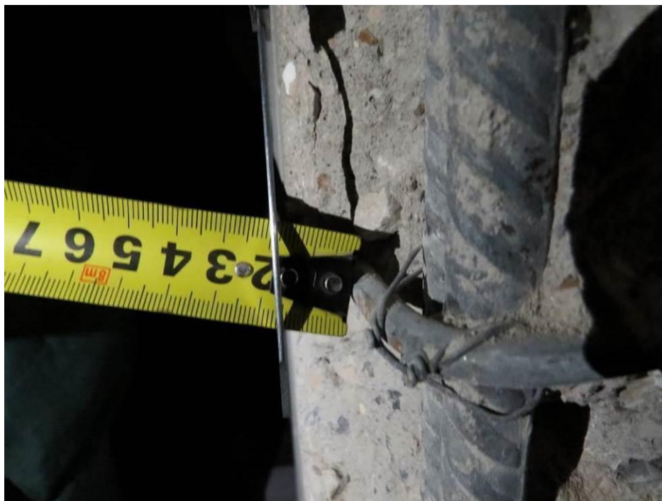
Рис. 3.2.6. Замер толщины защитного слоя пилона подвала между осями 20/1-21/1, ДД/1-ГГ/1
