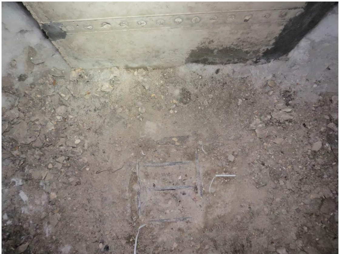
Рис. 3.3.6. Общий вид участка вскрытия монолитной ж.б. плиты перекрытия подвала возле пилона на пересечении осей Ю/1 и 20/1 (зона верхнего армирования)
