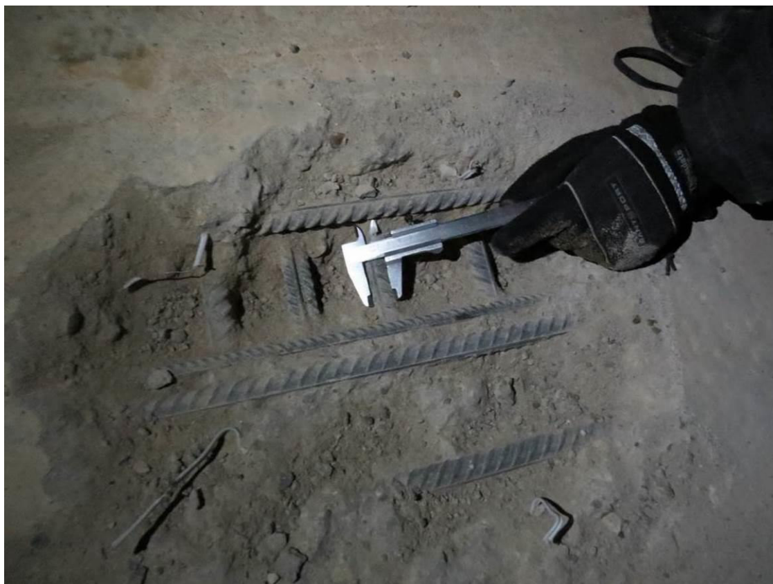
Рис. 3.1.9. Определение диаметра (20 мм) арматуры вдоль цифровых осей верхней зоны армирования фундаментной плиты секции 1 между осями ЖЖ/1-КК/1, 21/1-24/1
