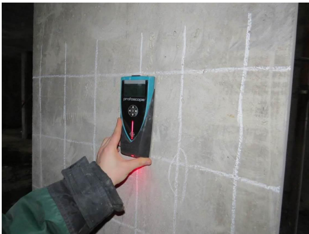
Рис. 4.4.1. Определение параметров армирования в монолитном железобетонном пилоне магнитным методом прибором Proceq Profoscope +
