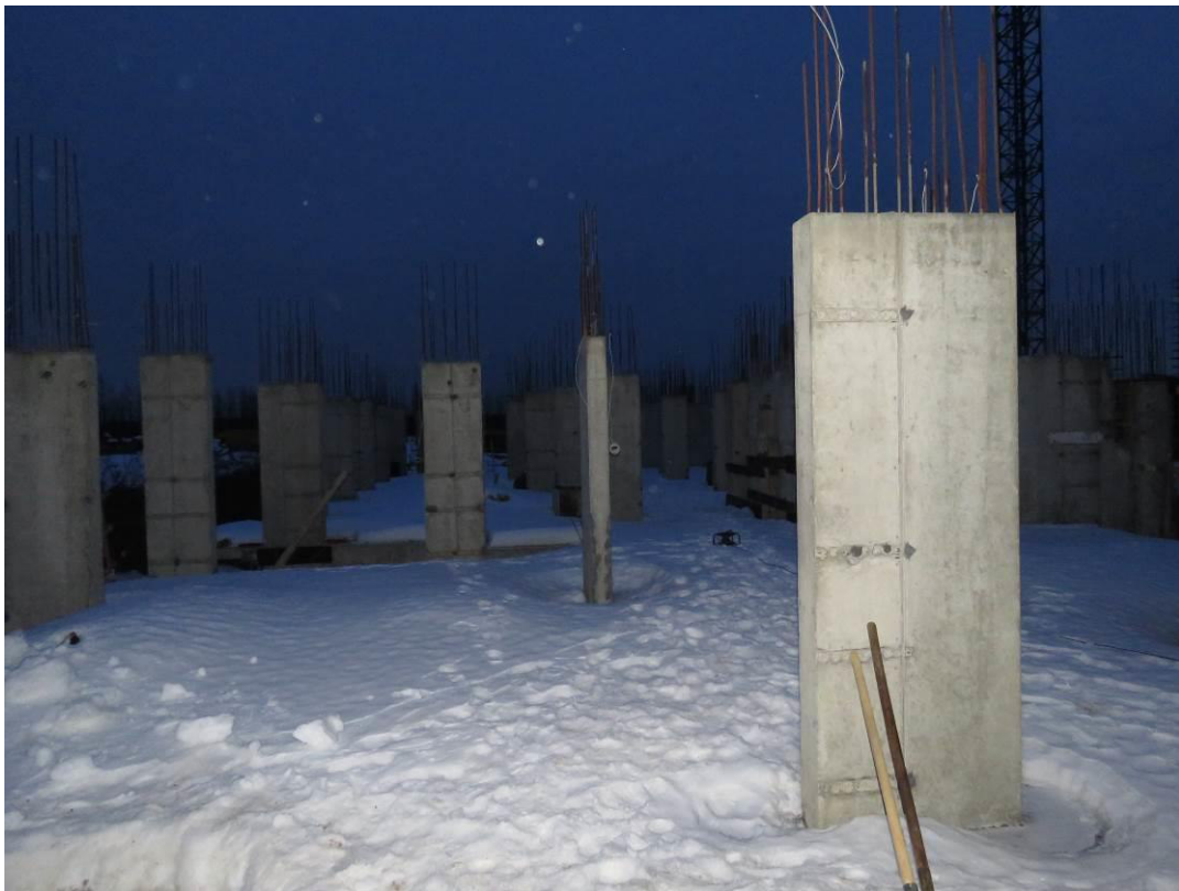
Рис. 1.6. Общий вид возведенных конструкций первого этажа секции №1
