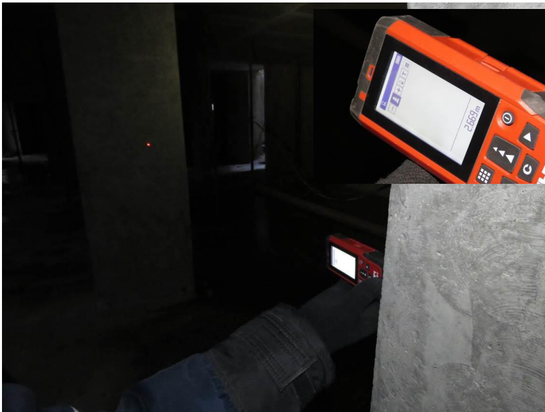
Рис. 2.3. Замер шага пилонов подвального этажа при помощи лазерного дальномера HILTI PD-1
