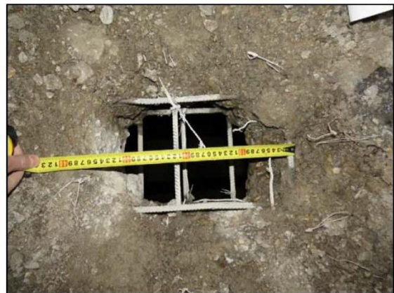
ФОТО 4. Уточнение шага рабочей арматуры монолитной железобетонной плиты перекрытия подвала между осями «22/1»-«23/1» и «ИИ/1»-«КК/1».
