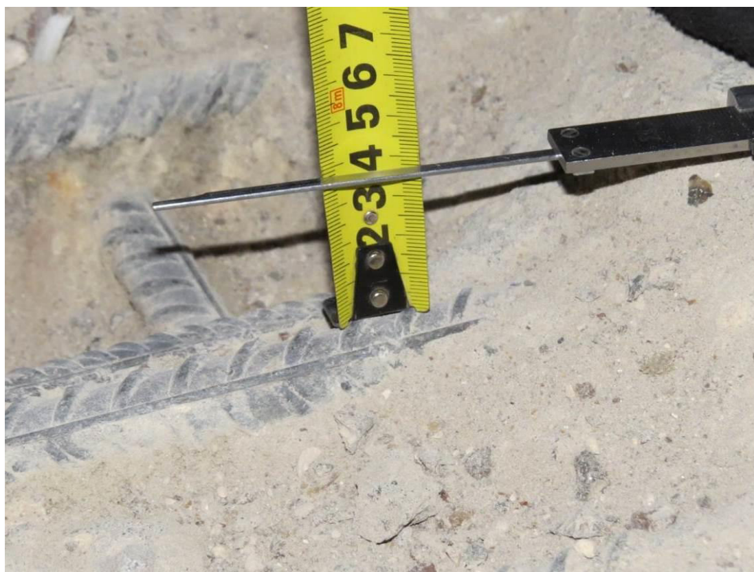
Рис. 3.1.10. Определение толщины (35 мм) защитного слоя бетона верхнего армирования фундаментной плиты секции 1 между осями ЖЖ/1-КК/1, 21/1-24/1
