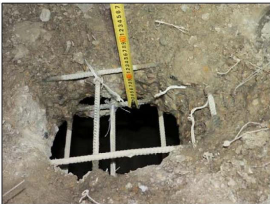
ФОТО 3. Общий вид вскрытия монолитной железобетонной плиты перекрытия подвала между осями «22/1»-«23/1» и «ИИ/1»-«КК/1».
