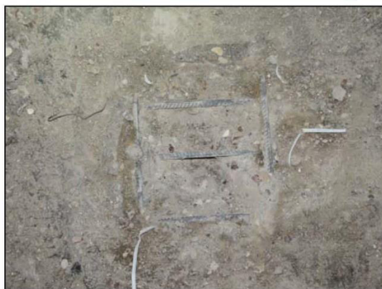
ФОТО 15. Общий вид вскрытия напольной поверхности железобетонной плиты перекрытия подвала на пересечении осей «Ю/1» и «20/1».
