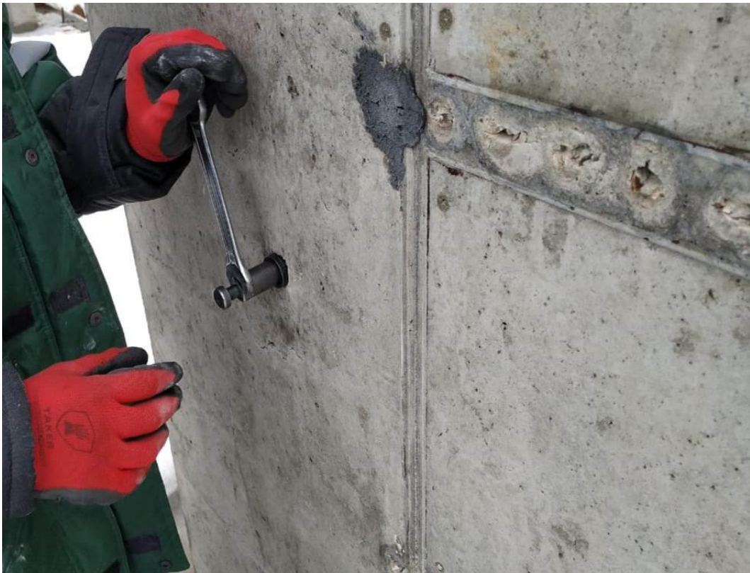
Рис. 4.2.3. Установка анкерного устройства и тяги в отверстии монолитного железобетонного пилона 1-го этажа
