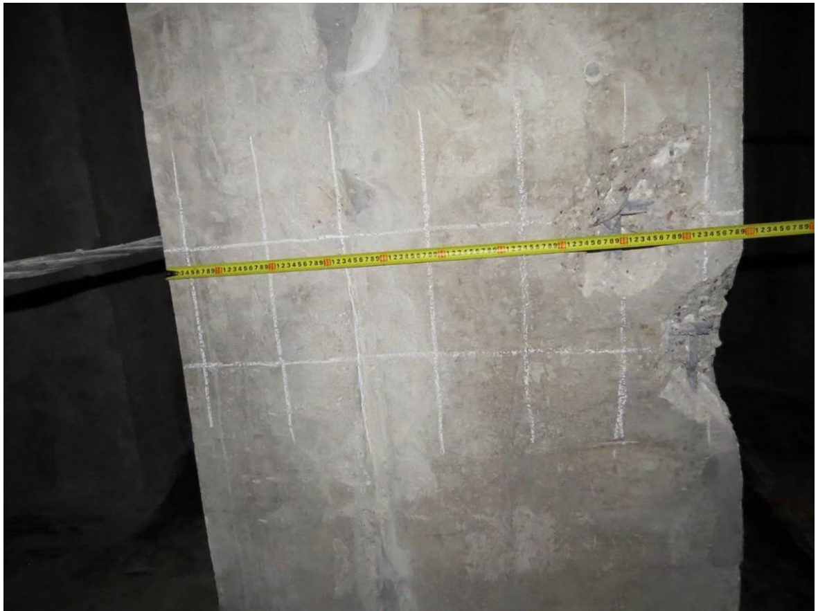
Рис. 3.2.3. Замер сечения монолитного ж.б. пилона подвала
