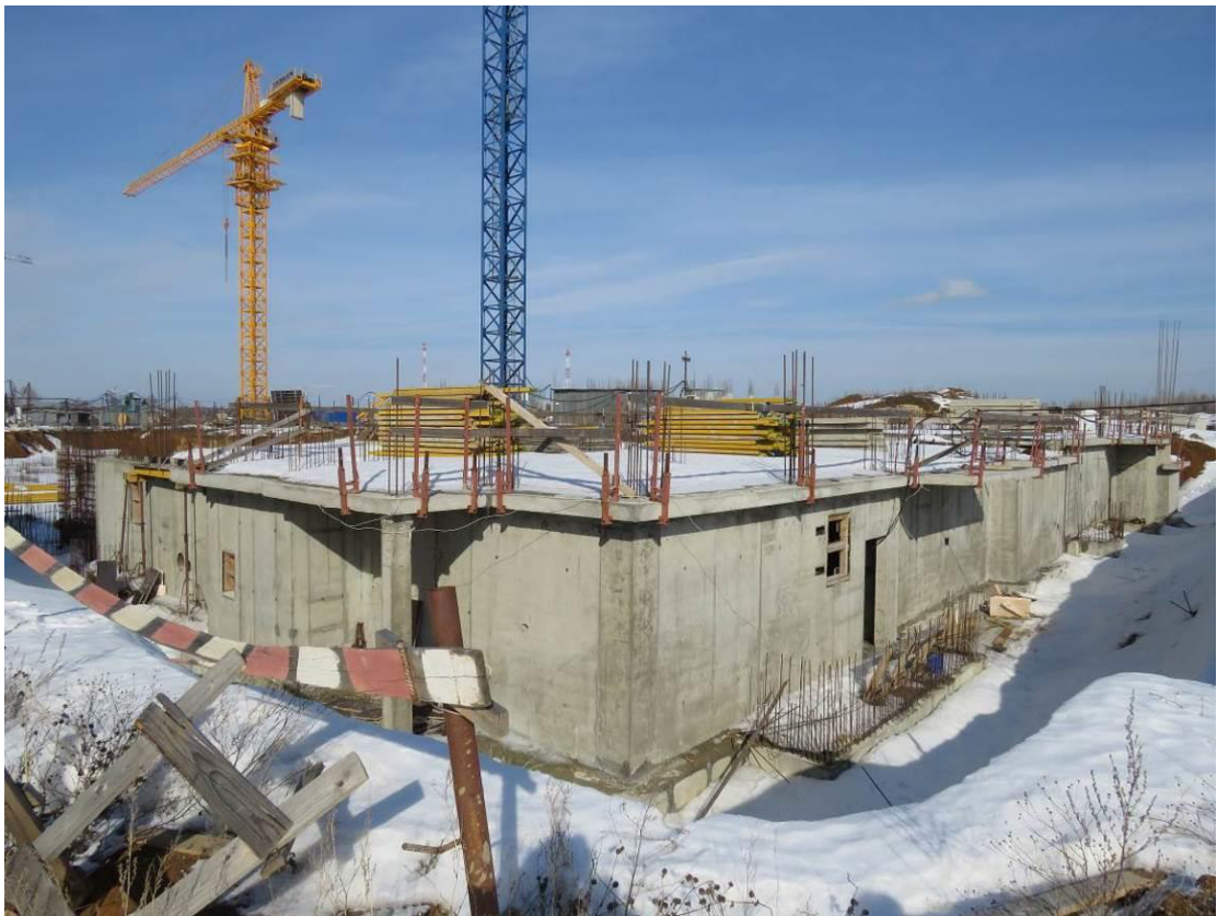
Рис. 1.4. Общий вид возведенных строительных конструкций секций №№4-5 жилого дома №18
