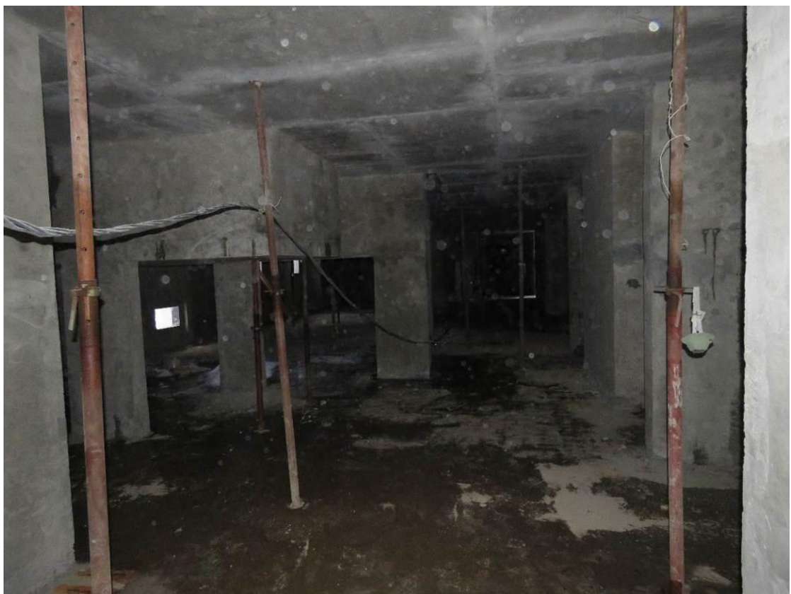
Рис. 3.3.2. Общий вид монолитной ж.б. плиты перекрытия подвала секции 3 здания
