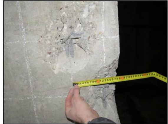
ФОТО 6. Уточнение шага рабочей арматуры монолитного ж/б пилона подвала по оси «КК/1» между осями «18/1» и «20/1».
