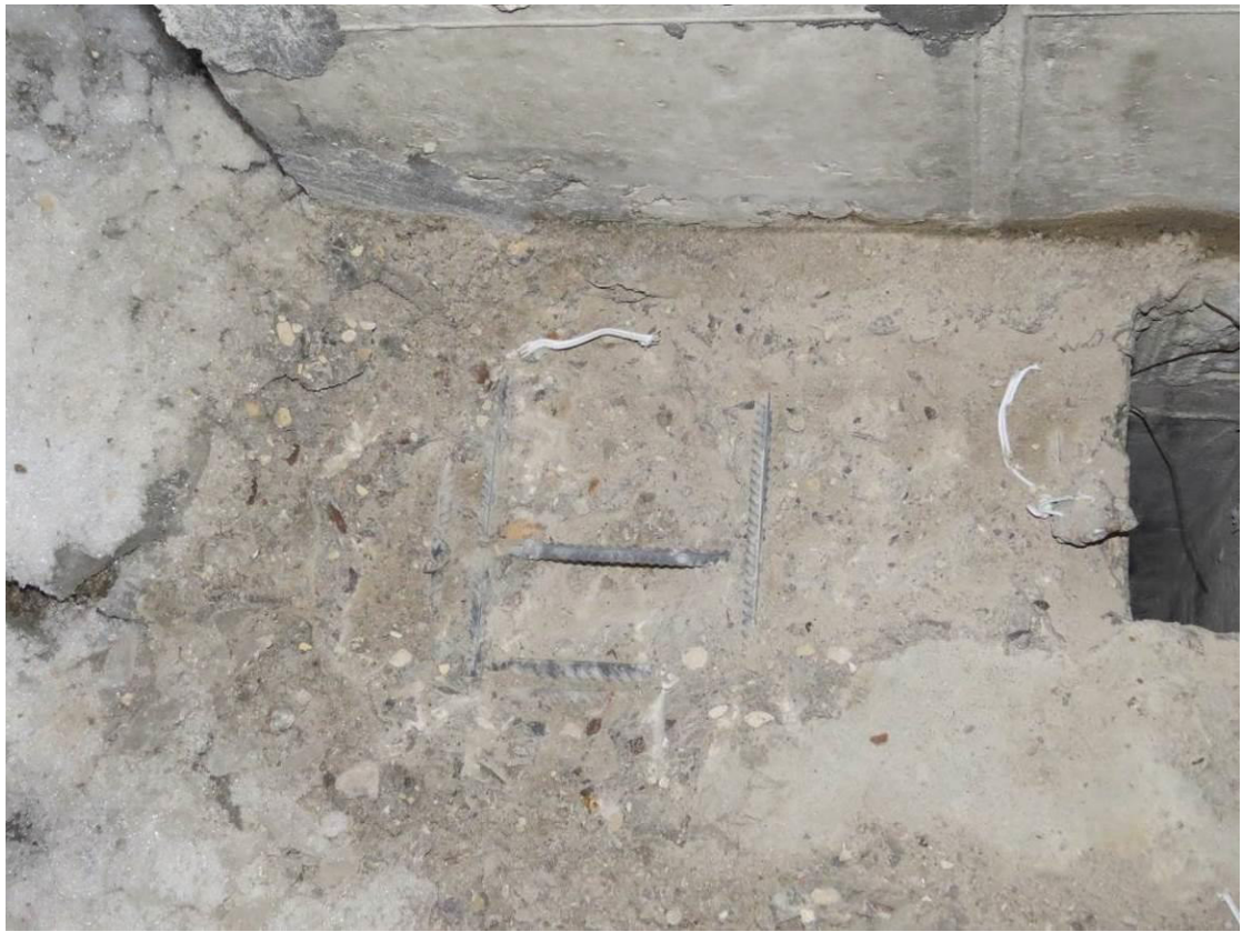
Рис. 3.3.5. Общий вид участка вскрытия монолитной ж.б. плиты перекрытия подвала возле пилона на пересечении осей Я/1 и 6/1 (зона верхнего армирования)
