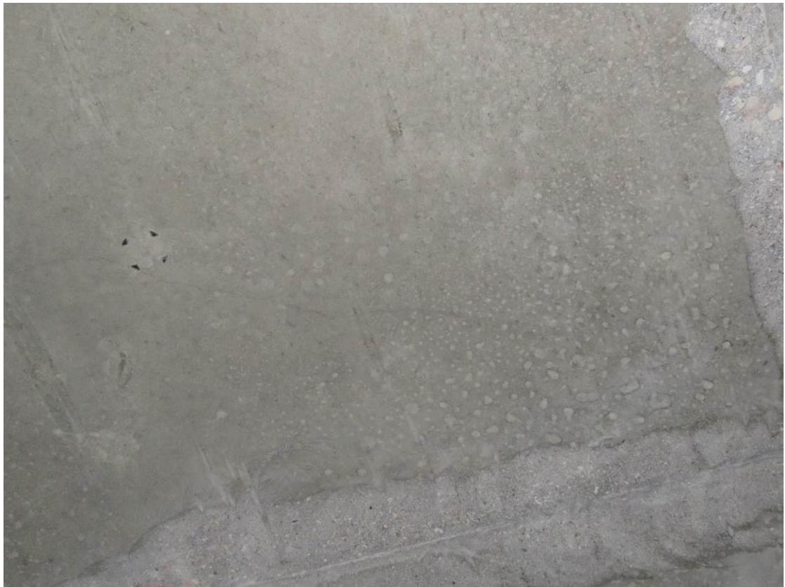
Рис. 3.3.8. (а, б). Общий вид трещин на потолочной поверхности плит перекрытий подвала шириной раскрытия до 0,1 мм
