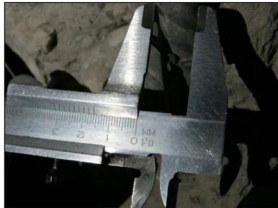
ФОТО 12. Уточнение диаметра рабочей арматуры железобетонного пилона расположенного между осями «20/1»-«21/1» и «ГТ/1»-«ДД/1».
