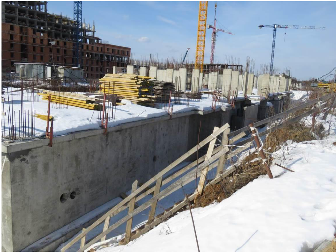
Рис. 1.1. Общий вид возведенных строительных конструкций секций №№1-3 жилого дома №18 по оси 27/1 между осями А/1-ММ/1
