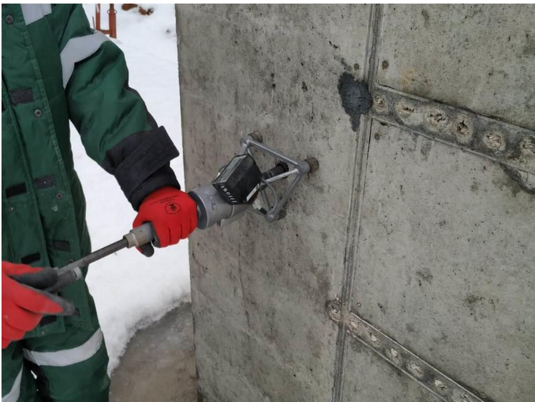
Рис. 4.2.4. Испытание бетона монолитного железобетонного пилона методом отрыва со скалыванием прибором ПОС 50МГ-4
