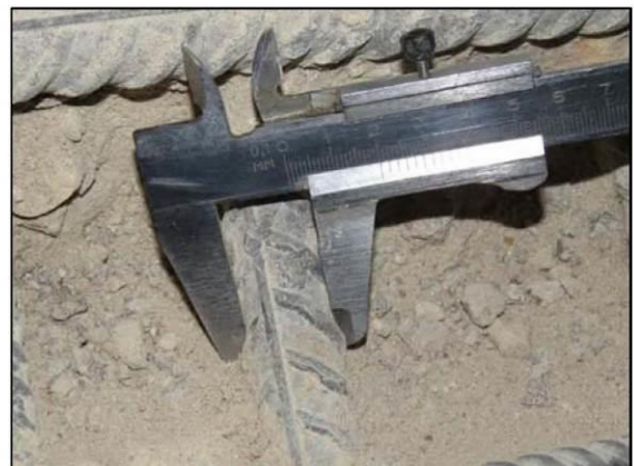
ФОТО 8. Уточнение диаметра рабочей арматуры монолитной железобетонной фундаментной плиты расположенной между осями «22/1»-«23/1» и «ИИ/1»-«КК/1».
