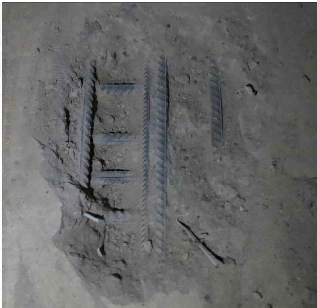
Рис. 3.1.4. Общий вид вскрытия фундаментной плиты секции 1 между осями ЖЖ/1-КК/1, 21/1-24/1
