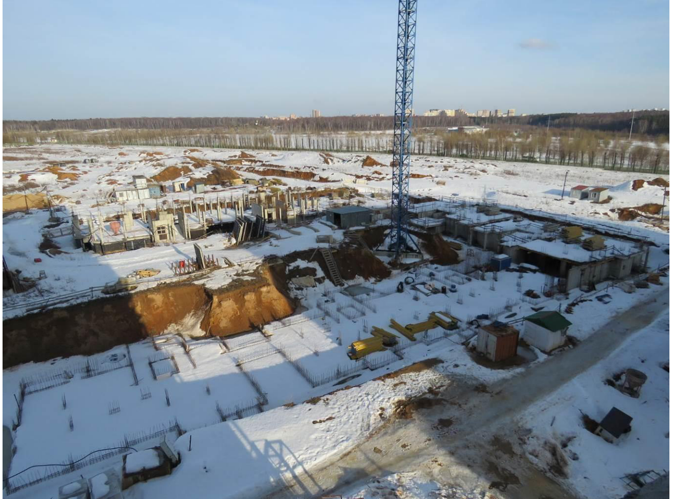
Рис. 3.6.1. Общий вид смонтированных конструкций здания. Отсутствие кровли
