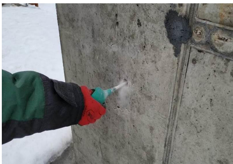
Рис. 4.2.2 . Продувка отверстия от пыли в монолитном железобетонном пилоне 1-го этажа
