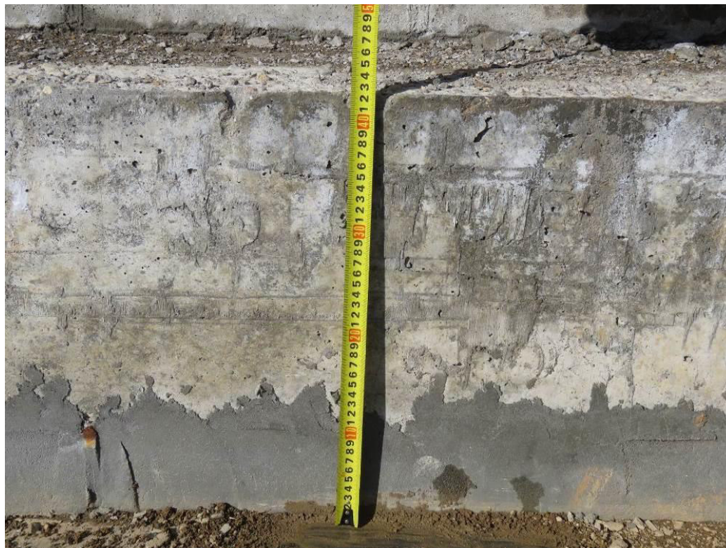
Рис. 3.1.3. Уточнение сечения фундаментной плиты секции №5 (420 мм)
