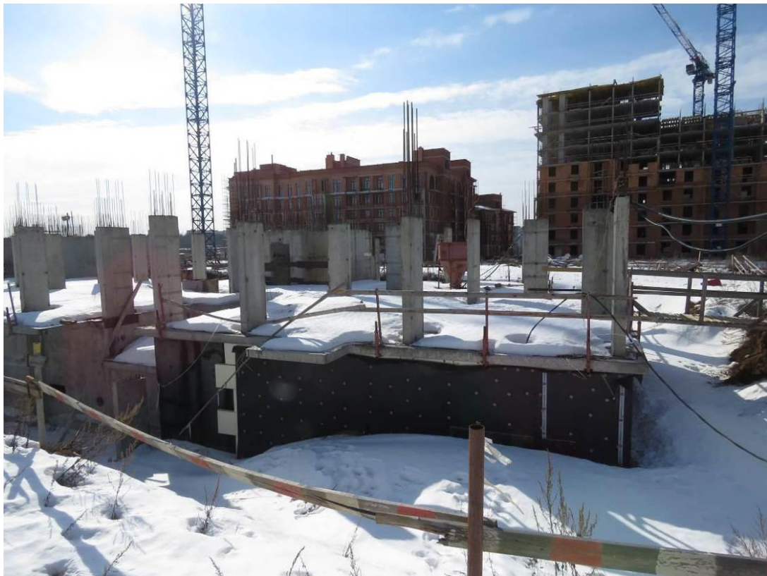
Рис. 1.2. Общий вид возведенных строительных конструкций секции №1 жилого дома №18
