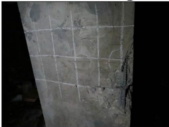
ФОТО 11. Общий вид вскрытия монолитного железобетонного пилона расположенного между осями «20/1»-«21/1» и «ГТ/1»-«ДД/1».
